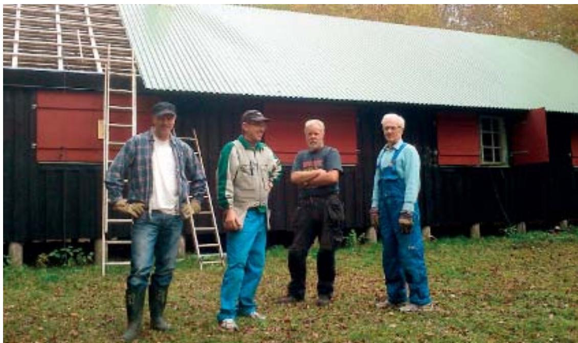
Renoveringsarbete är i full gång
