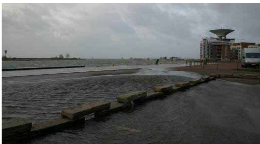
Vid storm och kraftig nederbörd kan vattnet komma från både havet och landsidans vattendrag.
