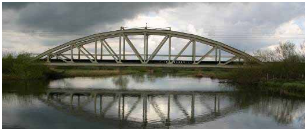
Järnvägsbro i Kristianstads vattenrike. Vattenståndet i ån påverkas av havets yta.
